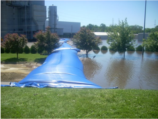
Water-filled dam © Hochwasserschutz Agentur
