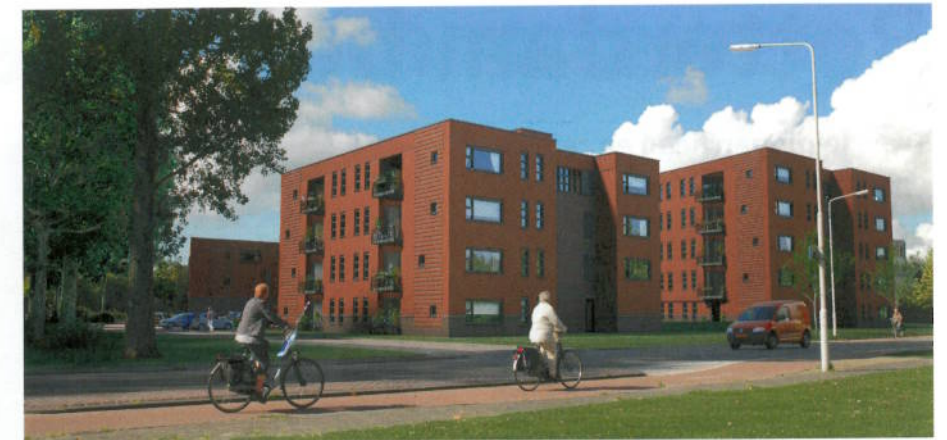
Nieuwbouw in de wijk Noorderhoek in Sneek, met vacuümtoiletten en groenvermalers.
