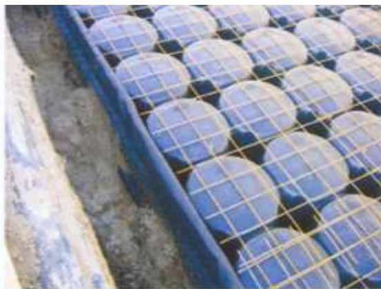
6. Het wapeningsnet wordt aangebracht op de cassettes, eventueel met afstandhouders.
