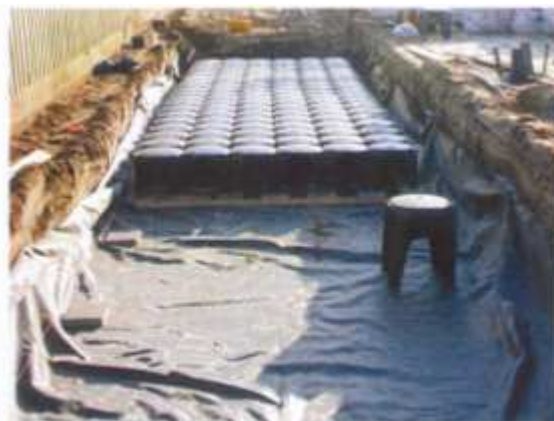
2. Het geotextiel en de betontegels worden geplaatst.
