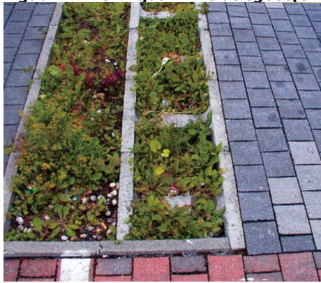
Figuur 11 ReinAqua-infiltratiegoot(onder) met Drainclean substraat (boven)
