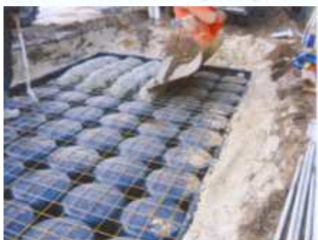
9. Het beton wordt gedoseerd aangebracht op de cassettes met een laadchop of betonpomp.
