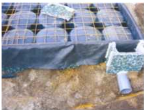
7. Leidingdoorvoer met XPE bekleding, in het infiltratieveld is een stortbed van betontegels aangebracht.
