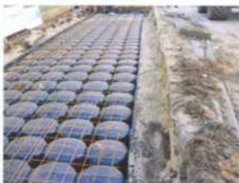
8. Aan de zijkanten wordt het zand los/vast aangevuld.
