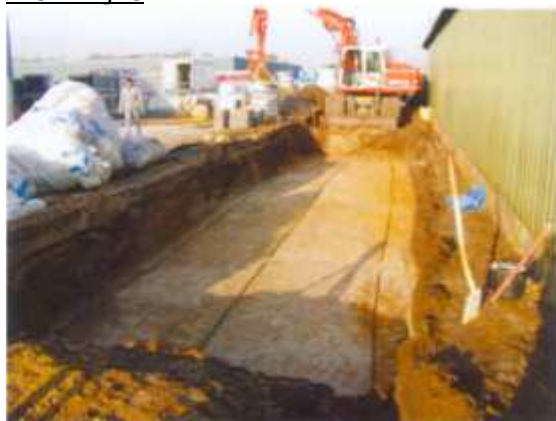
1. Het cunet wordt gegraven en zandpakket eventueel verdicht en uitgevlakt.
