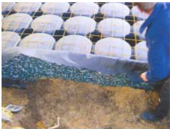
5. Het geotextiel wordt om de XPE platen gevouwen.
