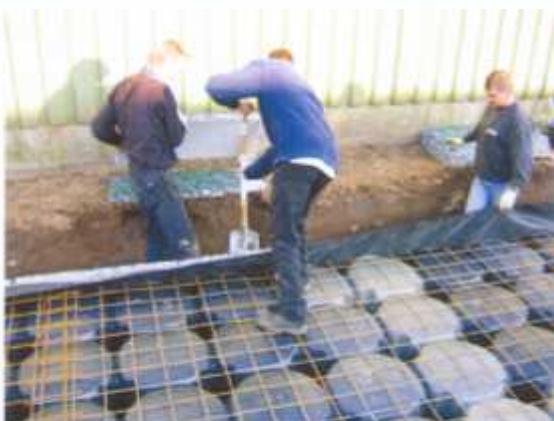
4. Aan de zijkanten worden waterdoorlatende XPE platen aangebracht.
