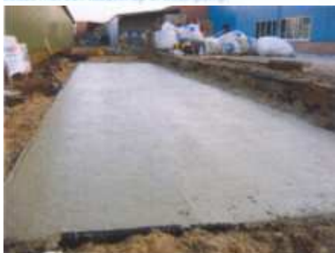
11. Het betondek wordt afgewerkt met een afwerkspaan, het infiltratieveld is gereed.
