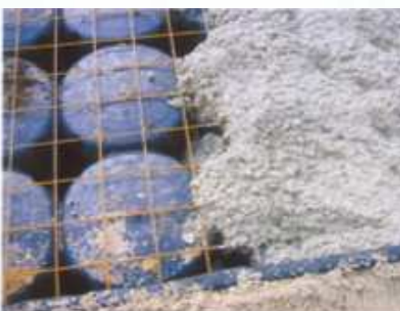
10. De kolommen worden gevuld met beton.
