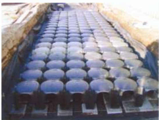
3. De Watershell cassettes worden met de kolommen op het midden van de betontegel geplaatst.
