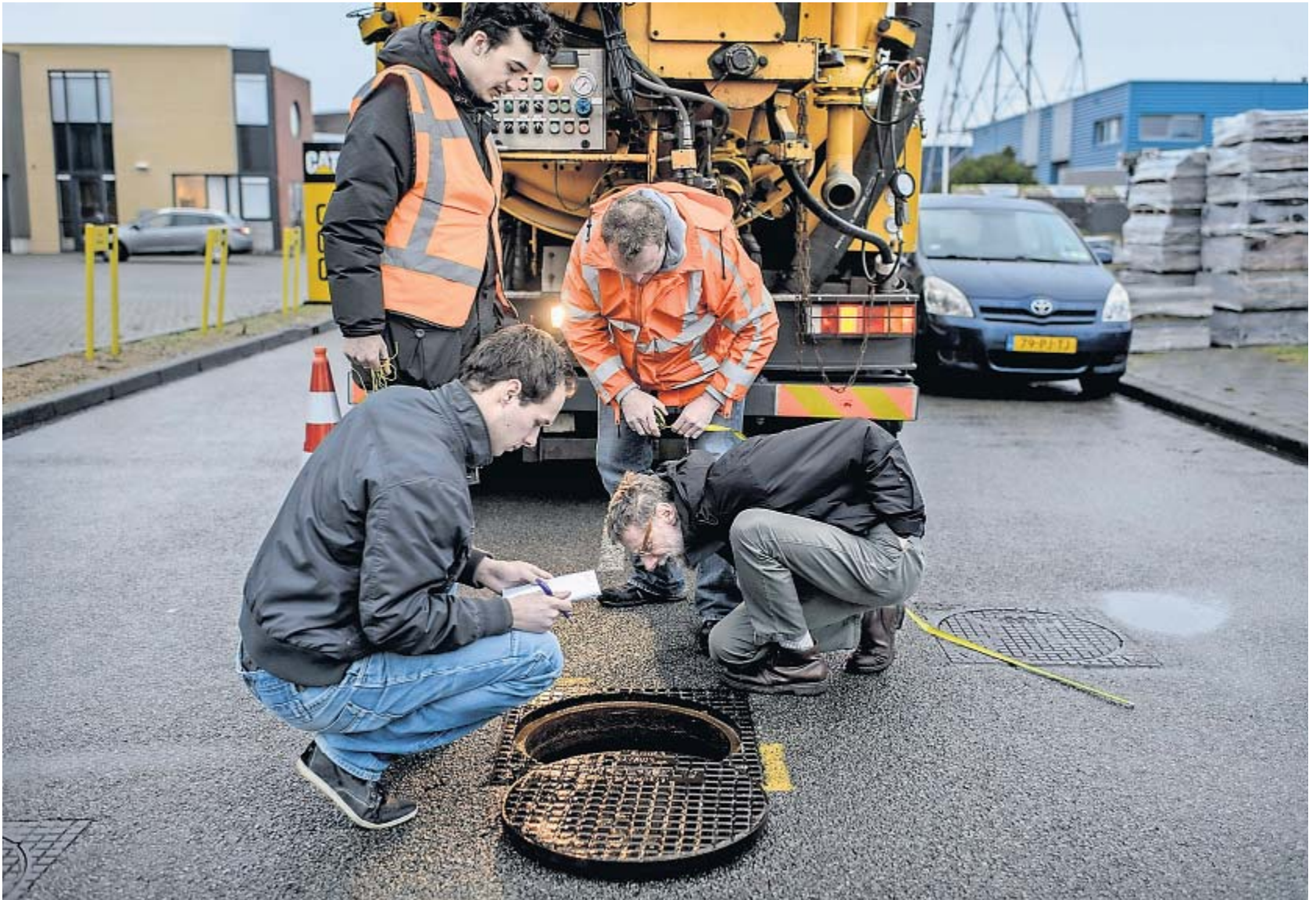
▲ Aan de Stavangerweg wordt de bijna vijftien jaar oude riolering getest. Enerzijds om te kijken naar de staat van het buizenstelsel, anderzijds wordt een nieuwe manier van schoonmaken en onderhoud getest. Foto Jan Zeeman
