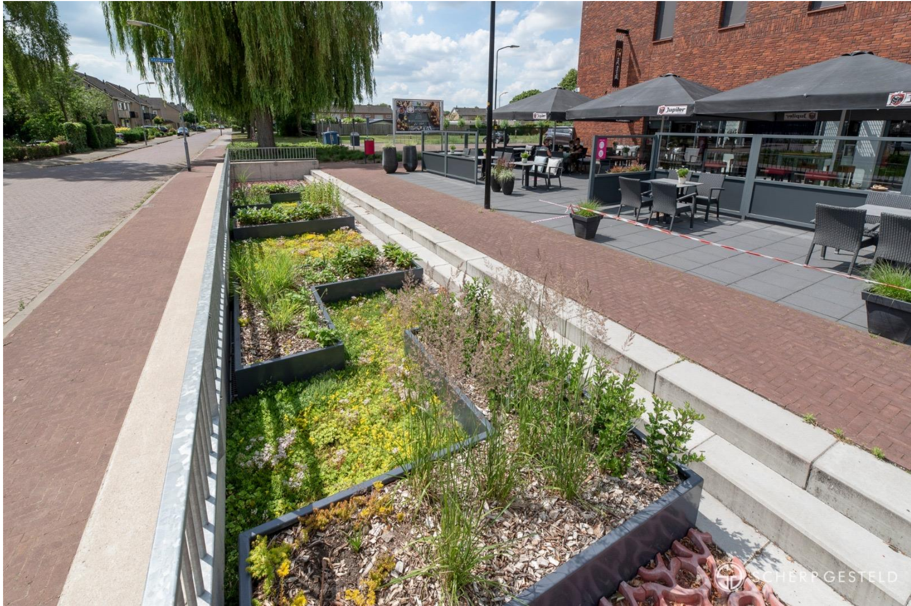
Afbeelding 2.2: waterretentie in Beneden-Leeuwen (foto: Thomas Klomp)
