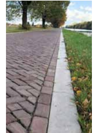
opsluitband: onder klik en afstroom water standaard grijs, beton
