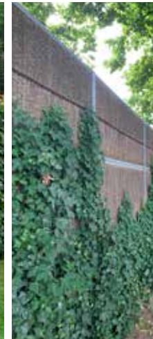
principe geluidsremmende constructie (10 kg/m 2 )
